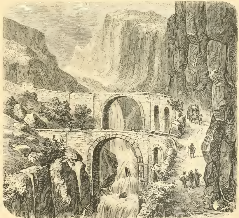
Nr. 4757. Teufelsbrücke auf der Gotthard-Strasse.
